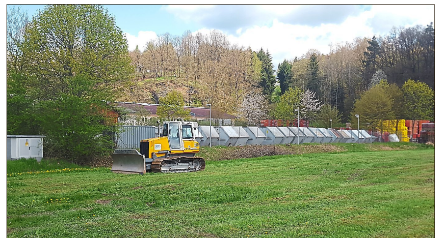
Die Erweiterung des Recyclinghofes beginnt, offizieller Spatenstich ist am 11. Mai. Fertig sein soll das neue Gelände zum Spätsommer.
